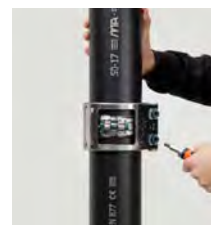
Växeldra de två bultarna med exempelvis en spärrnyckel. Monteringen är korrekt utförd när bultförbanden möts.
