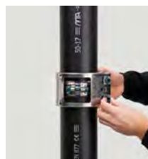
Växeldra de två bultarna med exempelvis en spärrnyckel. Monteringen är korrekt utförd när bultförbanden möts.
