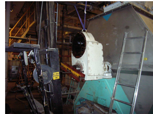
Demontering och montering Flenderväxlar Lantmännen Nrkp
