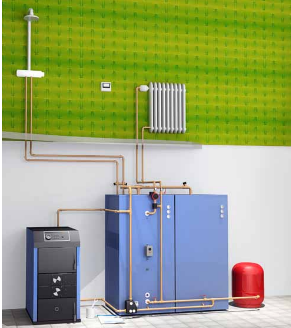
Bonus Light här monterad med två st Baxi Blå isolerade ackumulatortankar. Till systemet är en elpatron installerad.
