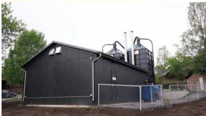
Exempel på anläggning som innehåller pannan NH200 samt silos för biobränsle.
