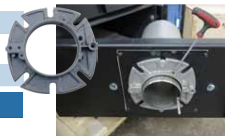
HSPB passar att montera i oljehålet på en panna.
