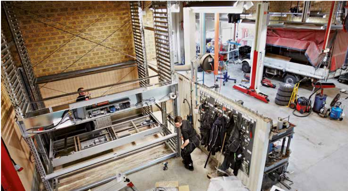
Atteviks Personvagnar AB – montering av Compact Lift. Compact Lift kan monteras i trånga utrymmen vilket ytterligare ökar vinsten med en hissautomat.
